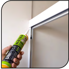
Box de Banheiro
