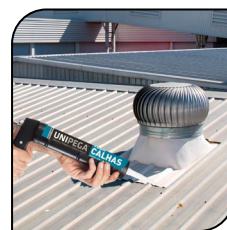
Sistema de Ventilação Industrial
