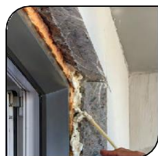
Instalación de puertas y ventanas
