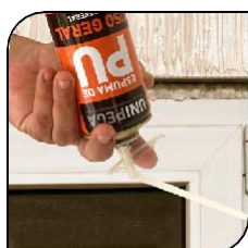
Instalación de puertas y ventanas
