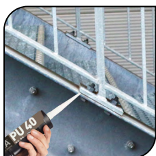
Escada de Metal
