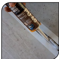
Junta de Dilatação
