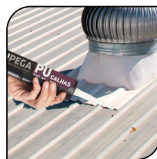
Sistema de Ventilação Industrial
